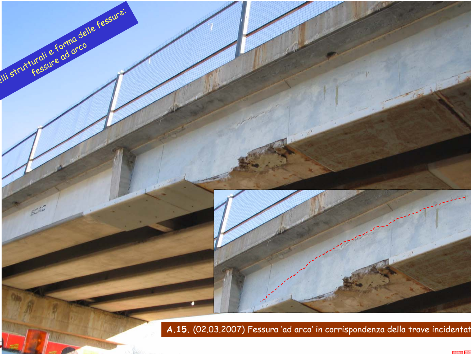
Foto. A.4. (16.11.2006) Vista dal basso della campata centrale. In primo piano la trave danneggiata
